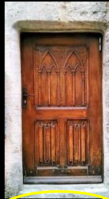
Rue Bellefont Arc surbaissé, XVIIIème siècle
